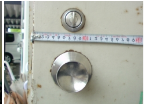
[バックセットの測定]
