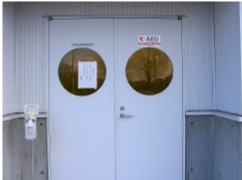
[外部より扉全体]
